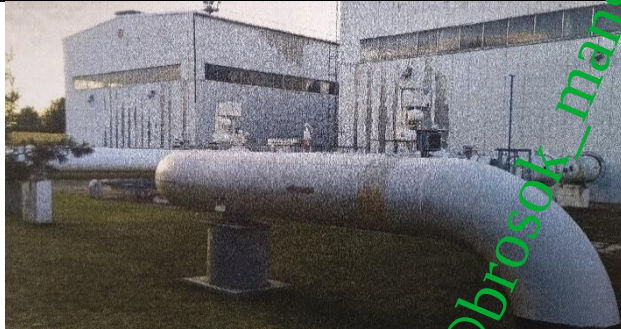
Рис. 1. Загальний вигляд вузлу підключення компресорної станції до магістрального газопроводу
